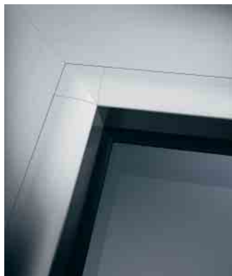
Штапик с угловым элементом Glazing bead with corner piece
